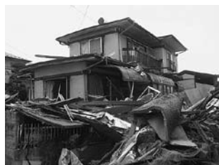
写真4 浸水深2m程度の住宅地。なんとか形状を保っているが1階部分は壊滅（多賀城市）
