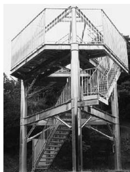
写真5 三重県志摩市・畔名地区津波避難タワー
