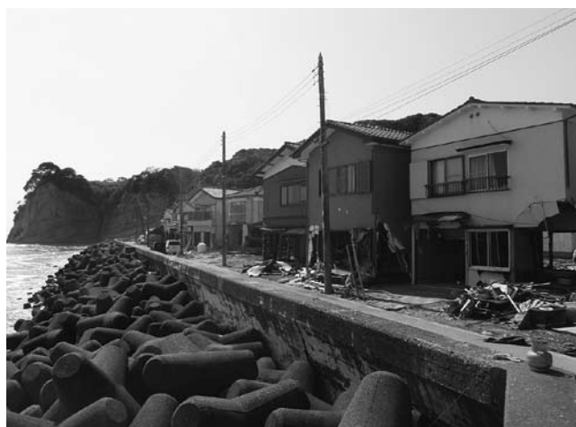
図8 護岸背後の被災家屋
