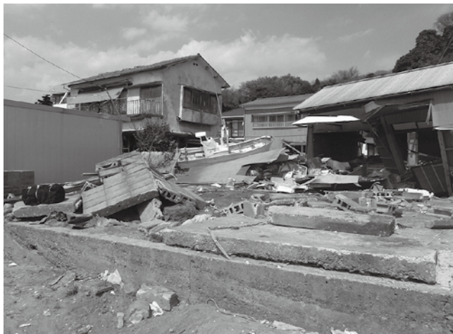
図9 津波で被災した家屋
