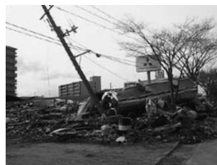
写真6 仙台港フェリーターミナル駐車場のタンクローリーの漂流（仙台区 浸水深約3～4m）
