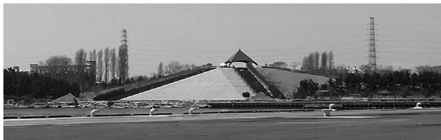
写真8 下部の集会所などは破損があったが、200万㎡の土砂を積み上げている丘陵全体はまったく影響を受けていない。大規模な盛り土構造物は、津波抵抗力の大きさを示している（仙台新港中央緑地）
