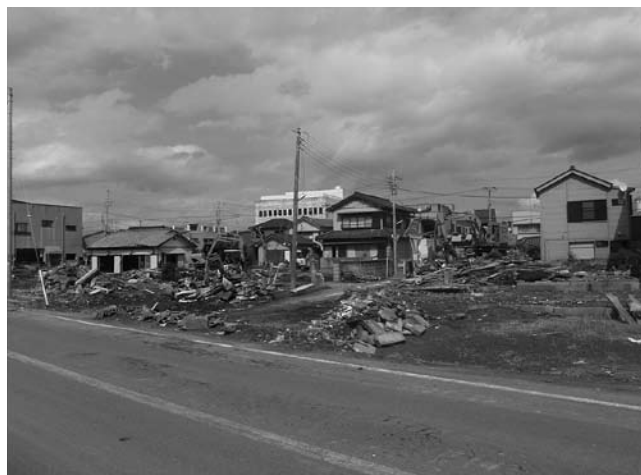
図6 津波で被災した家屋
