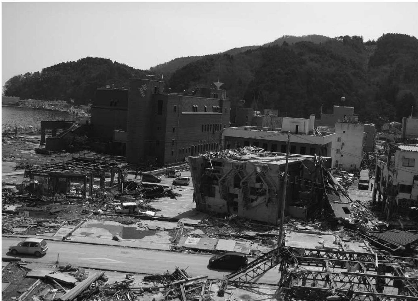
写真4 転倒した RC 造の建物(女川)
