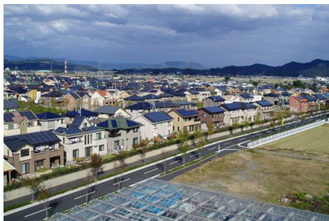
写真 NEDO委託研究 「集中連系型太陽光発電システム実証研究」
