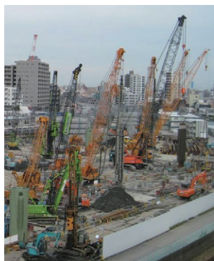
写真-4. 杭施工状況
