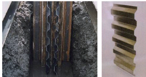
写真-6. CWSジョイント工法施工状況およびジョイント波形鋼板
