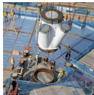
写真-1. 塔体最下部鉄骨建方
