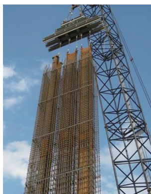
写真-5. SRC鉄筋籠
