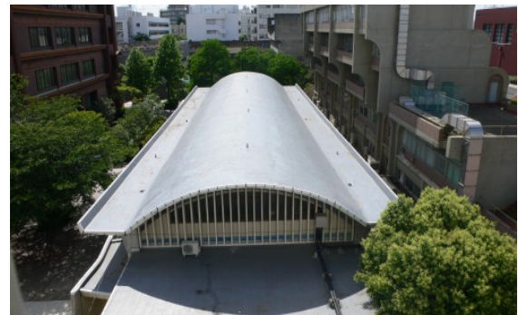
写真2 シェル構造物の一例（日大生産工学部実験棟） 構造担当：加藤渉・本岡順二郎（1959年竣工）
