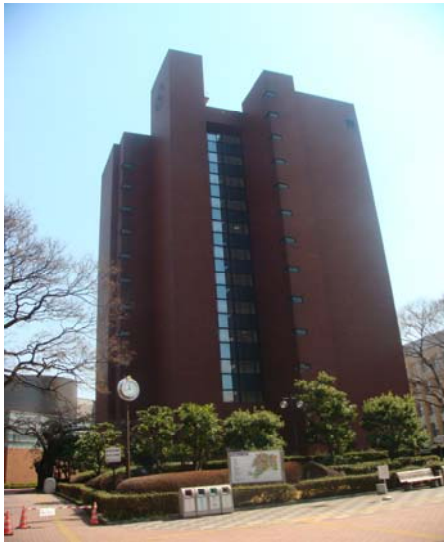
写真1. 重層構造物の一例（日大文理学部研究棟） 振動解析担当：新宮清志（1979年竣工）
