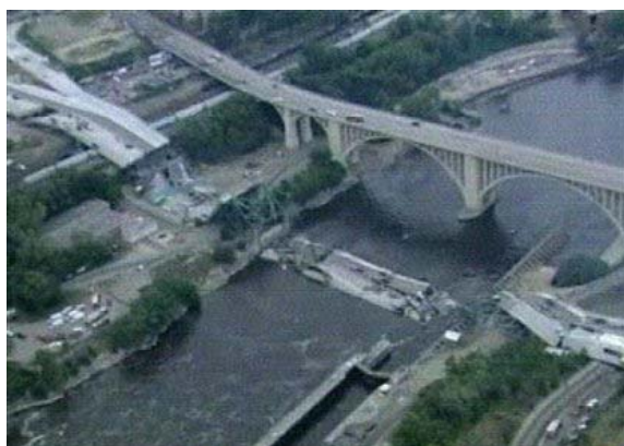
図4 崩壊したミネソタのトラス橋(2007年8月2日)
